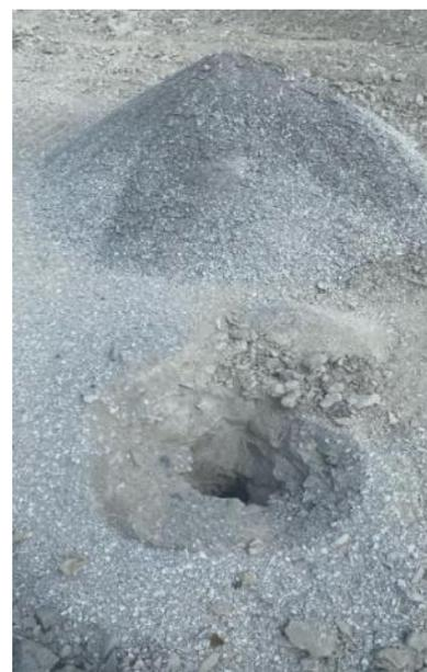
Рисунок 3 – Горка шлама рядом с устьем скважины.
