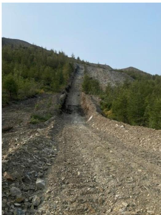
Рисунок 1 – Демонстрация проходки канавы (Фото: Лынов Д.А.)
