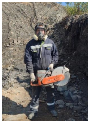
Рисунок 2 – Процесс проходки бороздовой линии
