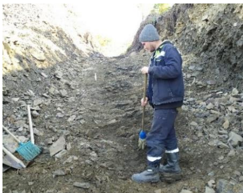
Рисунок 1 – Процесс зачистки канавы
