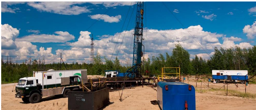
Рисунок 1 – Станция ГТИ в работе на скважине
