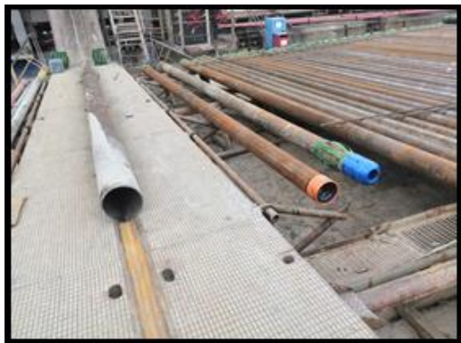
Рисунок 2 – Подготовка к спуску обсадных труб направления
