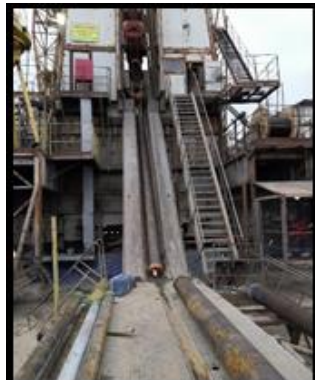
Рисунок 3 – Спуск обсадных труб направления
